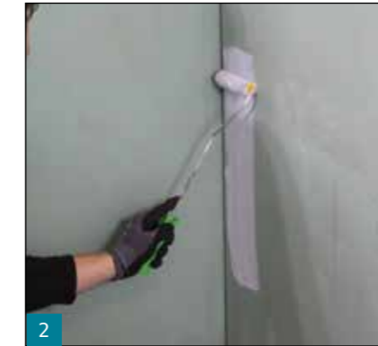
2 Bei den Wassereinflussklassen WO-I – W2-I (Wand) wird MULTIPROOF® in zwei Schichten mit einer Gesamttrockenschichtdicke von mindestens 0,5 mm aufgetragen.
