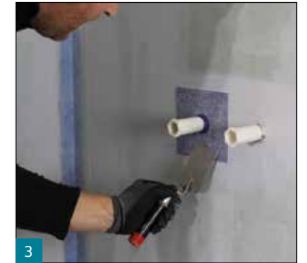
3 Das Systemdichtband SB 78 und die Dehnzonenmanschetten SB 100 werden in die erste Lage der Abdichtung eingearbeitet.
