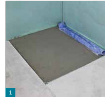
1 Saugende Untergründe können zur Staubbindung vorab mit D 11 oder D 1 Speed grundiert werden. Mineralische Untergründe müssen mattfeucht sein bzw. vorgemischt werden.
