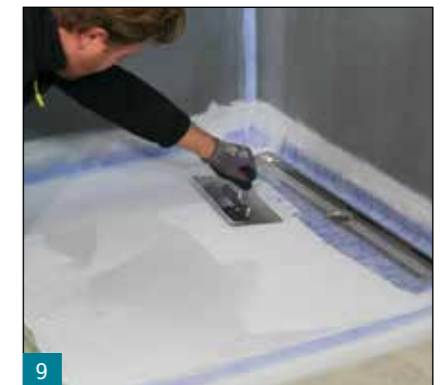
9 Nach vollständiger Durchtrochnung der ersten Lage wird die zweite Lage aufgebracht. Optische Durchtrochnungskontrolle: Farbtonwechsel von hell- zu dunkelgrau
