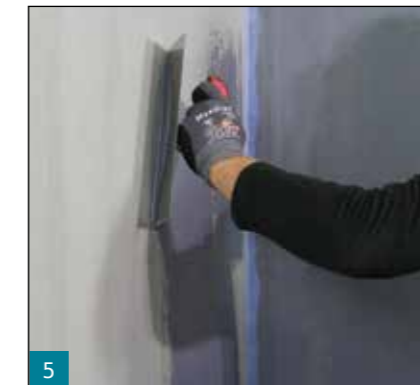
5 MULTIPROOF® kann wahlweise gerollt, gespachtelt, gestrichen oder maschinell gespritzt werden. Auf porigen und lunkerreichen Untergründen vorab eine Kratzspachtelung mit MULTIPROOF® aufbringen und trocknen lassen.
